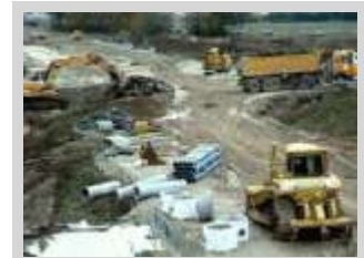
Auf der Baustelle
